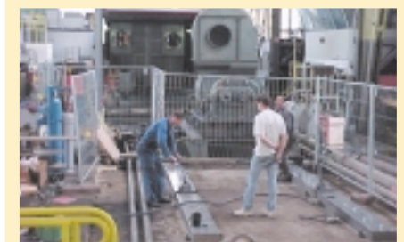
Trabajo en progreso en el nuevo banco de pruebas de HMA
